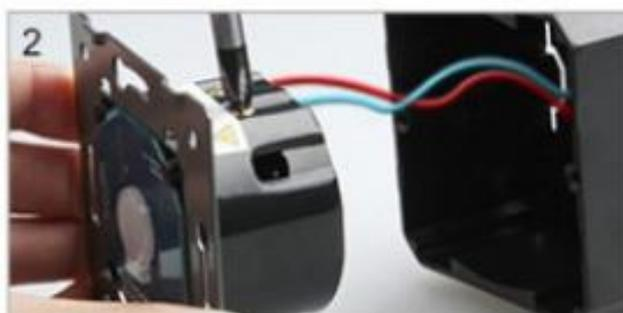
Conecte los cables y apriete los tornillos
